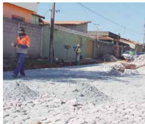
Obras de calçamento da Rua Josafá Abreu no Bairro São João I
