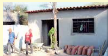
Novas instalações da Coordenadoria de Vigilância Sanitária
