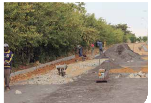
Obras de calçamento da Rua Joaquim Francisco dos Anjos no Bairro Jardim Padre Pedro
