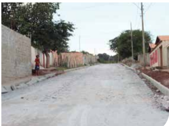
Rua Jacó Braga no Bairro São João II
