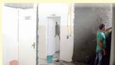
Reforma dos banheiros no prédio da Unidade Central de Saúde
