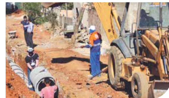
Foram instalados aproximadamente 160 m de manilhas de 600mm e 32 m de manilhas de 1000mm para dar vazão ao grande volume de água das chuvas que passa pelo local
