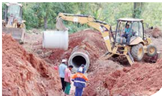
Foram instalados aproximadamente 160 m de manilhas de 600mm e 32 m de manilhas de 1000mm para dar vazão ao grande volume de água das chuvas que passa pelo local
