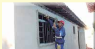
Obras da nova sede da Secretaria de Saúde
