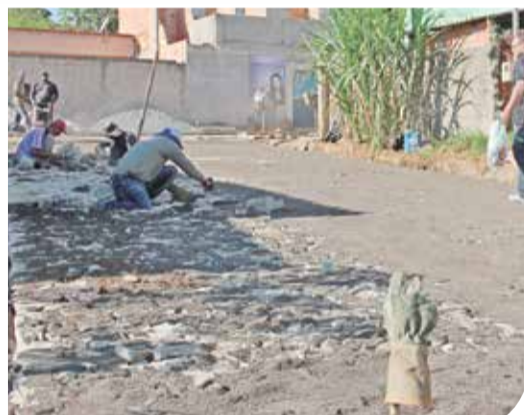
Calçamento de ruas no Bairro Campo Limpo
