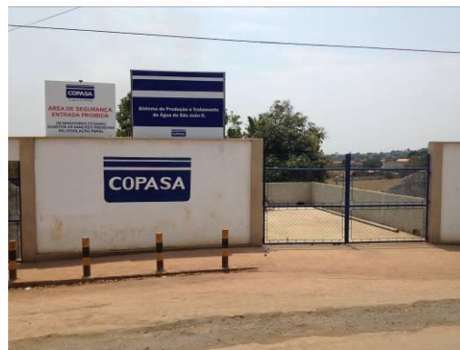
Figura 3: Sistema de Produção e Tratamento de Água Bairro São João II Fonte: Prefeitura de Prudente de Moraes, 2014
