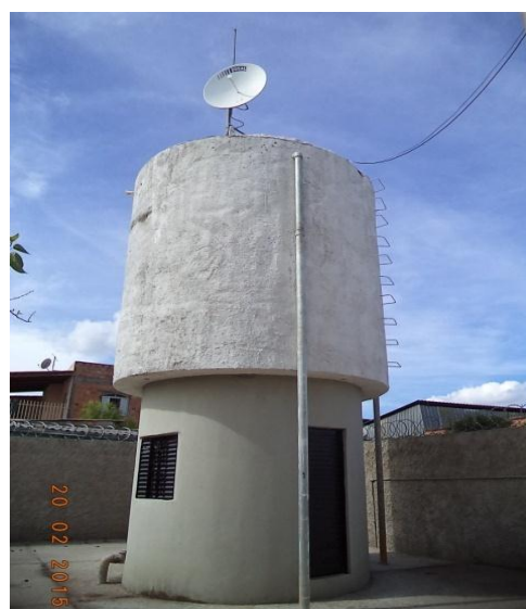
Figura 57: Reservatório (R6) Fonte: Prefeitura Prudente de Moraes, 2015.
