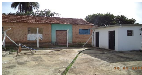
Figura 59: Poço Creche em Campo de Santana
