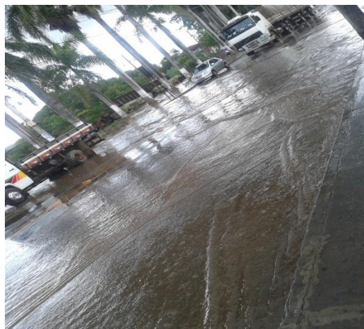
Figura 124: Alagamento na MG-424
