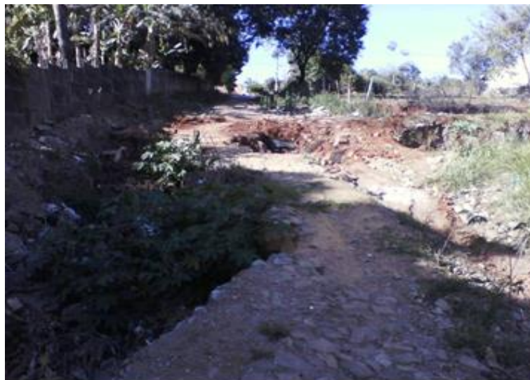
Figura 125: Erosão da Rua Fábio de Souza no bairro Emília Fonte: Prefeitura Prudente de Morais
