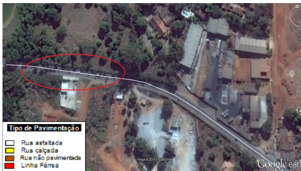
Figura 120: Ponto de alagamento na sede de Prudente de Morais I - MG-424 Fonte: Prefeitura Prudente de Morais, 2015.
