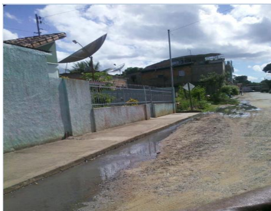
Figura 73: Esgoto a céu aberto Rua Lael Ferreira
