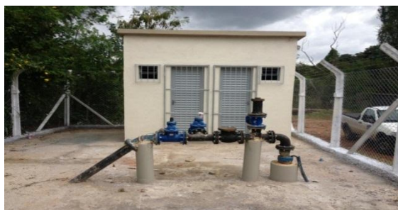
Figura 58: Poço C01 em Campo de Santana
