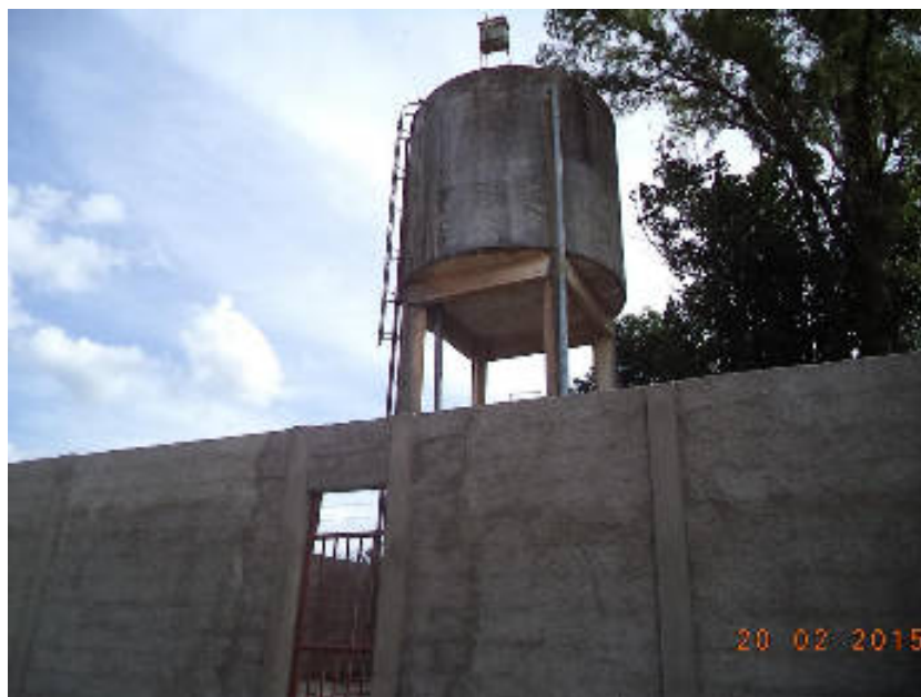
Figura 60: Reservatório (R7) Fonte: Prefeitura Prudente de Morais, 2015
