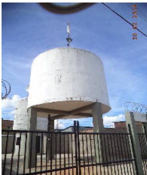
Figura 56: Reservatório (R5) Fonte: Prefeitura Prudente de Morais, 2015.
