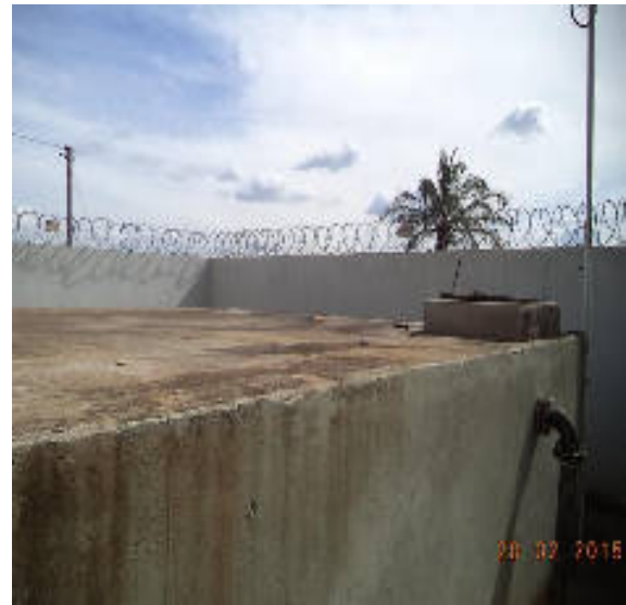
Figura 55: Reservatório (R4) Fonte: Prefeitura Prudente de Morais, 2015.
