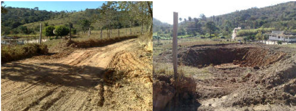
Figura 117: Obra de drenagem pluvial na estrada de Matos Fonte: EMATER, 2013
