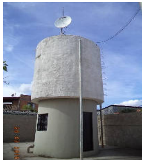
Figura 57: Reservatório (R6) Fonte: Prefeitura Prudente de Morais, 2015.
