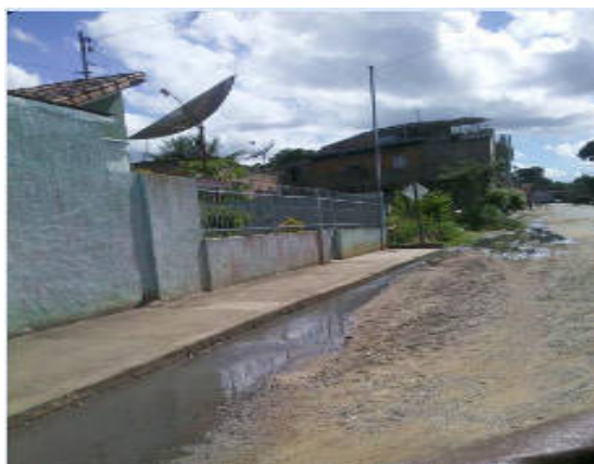
Figura 73: Esgoto a céu aberto Rua Lael Ferreira
