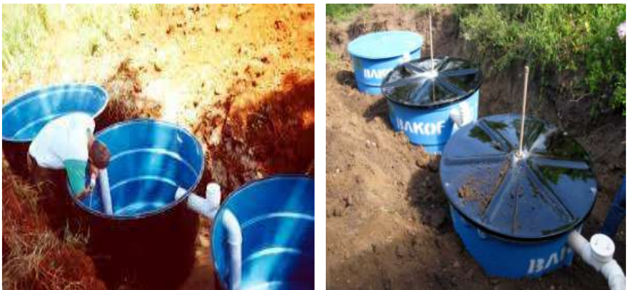
Figura 38: Fossas sépticas EMATER
