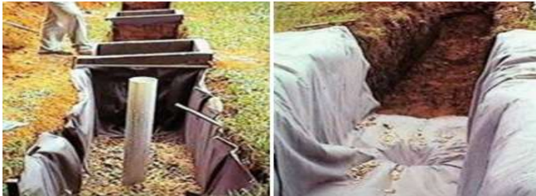
Figura 57: Exemplos de trincheira de infiltração
