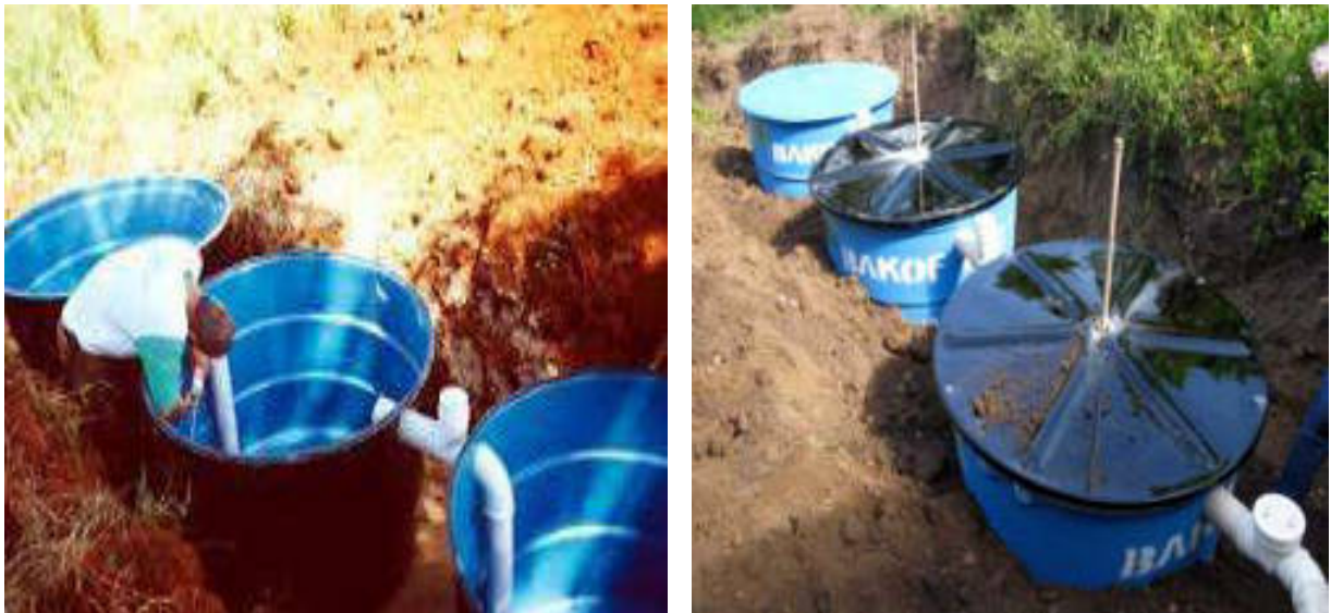
Figura 38: Fossas sépticas EMATER
