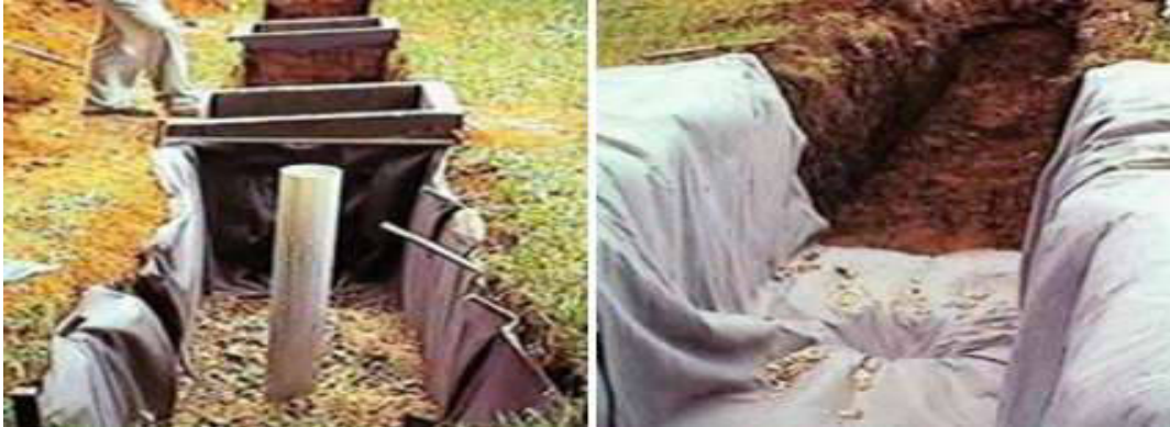
Figura 57: Exemplos de trincheira de infiltração
