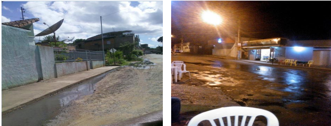
Figura 9: Esgoto a céu aberto nas ruas da Sede de Prudente de Morais
